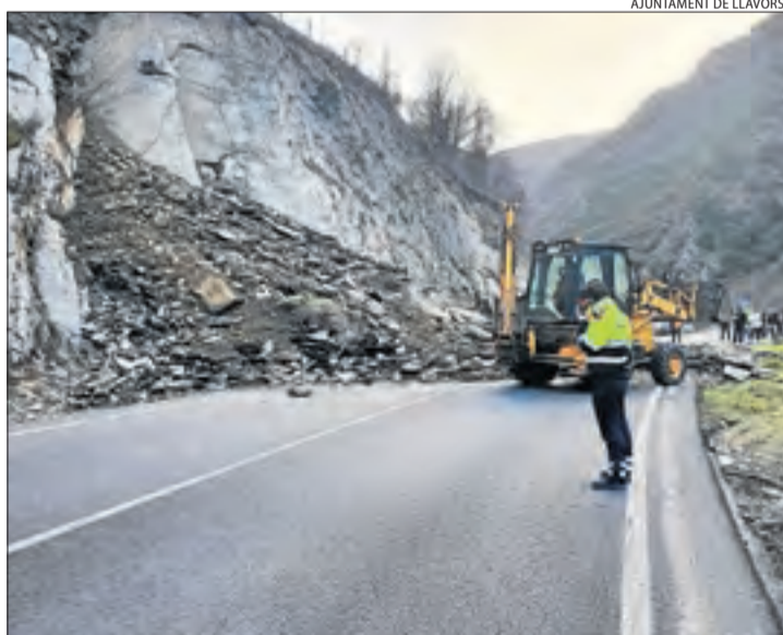
Els treballs per retirar les roques caigudes sobre la C-13.
