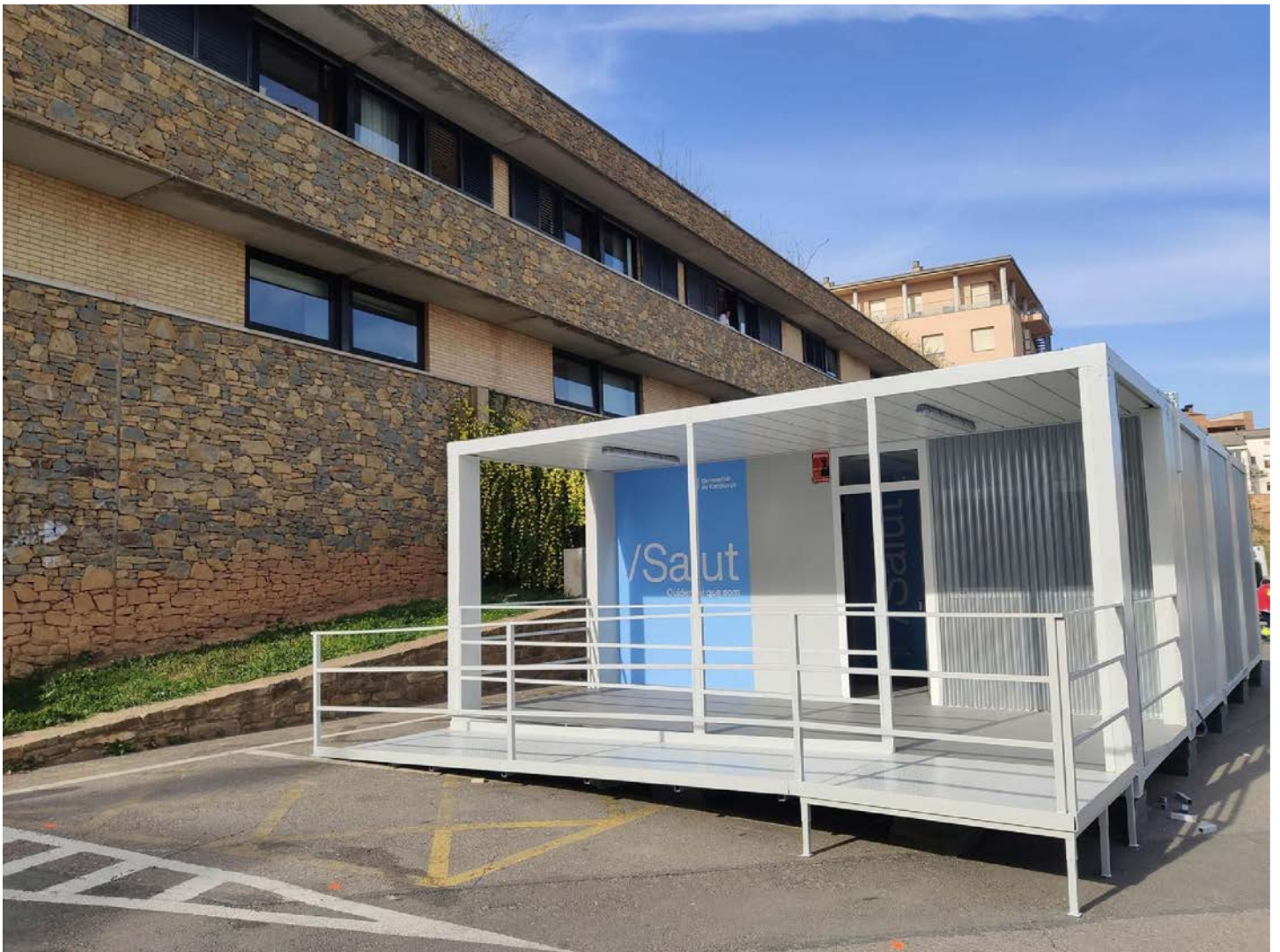
El mòdul instal·lat a Trepç SALUT
