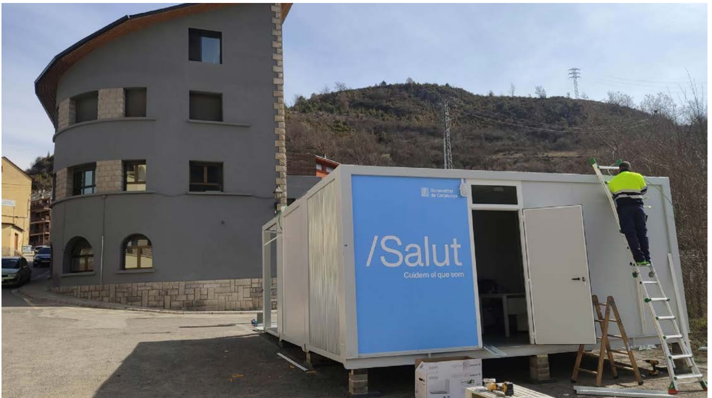
El mòdul instal·lat al Pont de Suert SALUT
