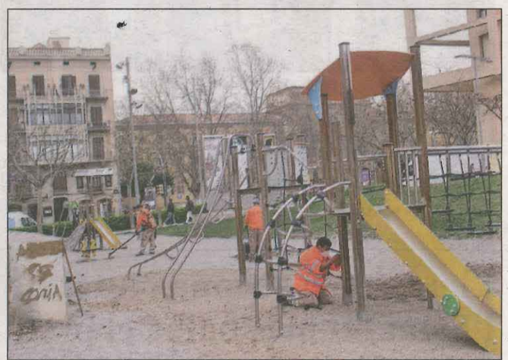
FOTO: T.A. / Operaris arranjan la superfície del parc infantil
