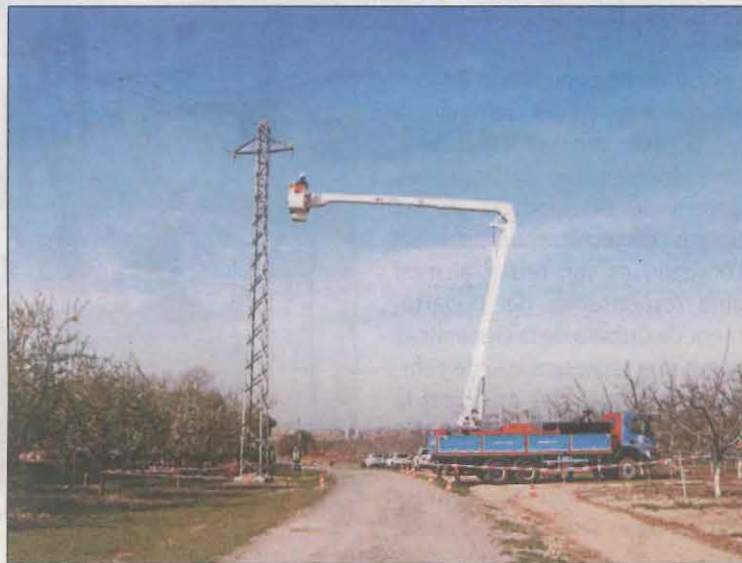
FOTO: ACN/ Operaris substituint elements d'una torre a Gimenells
