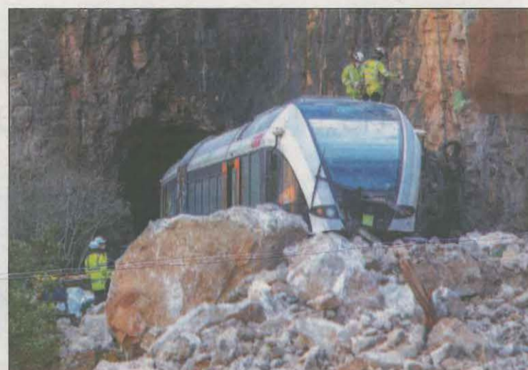
FOTO: FGC/ Els operaris treballant a la zona afectada per l'esllavissada
