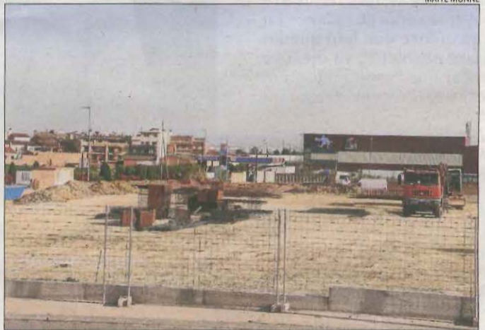
Les obres de la nau de Correus Express a Torrefarrera.
