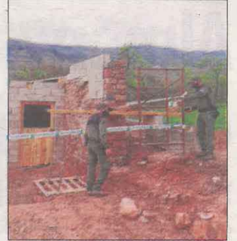
Les obres precintades.
