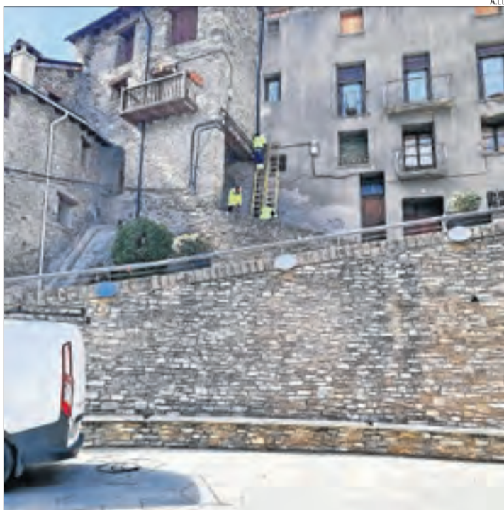
Les obres de desplegament de fibra òptica aquests dies a Llavorsí.
