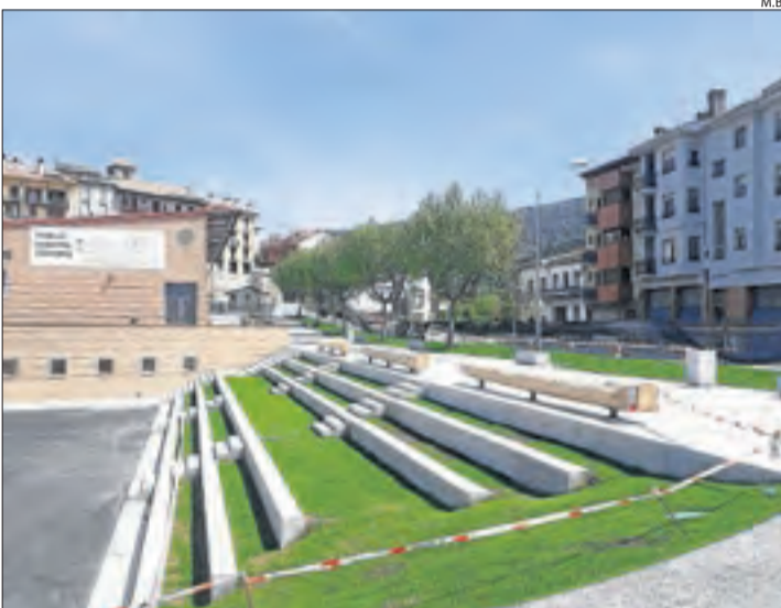
Estat actual del nou passeig a la travessia de l'N-260.
