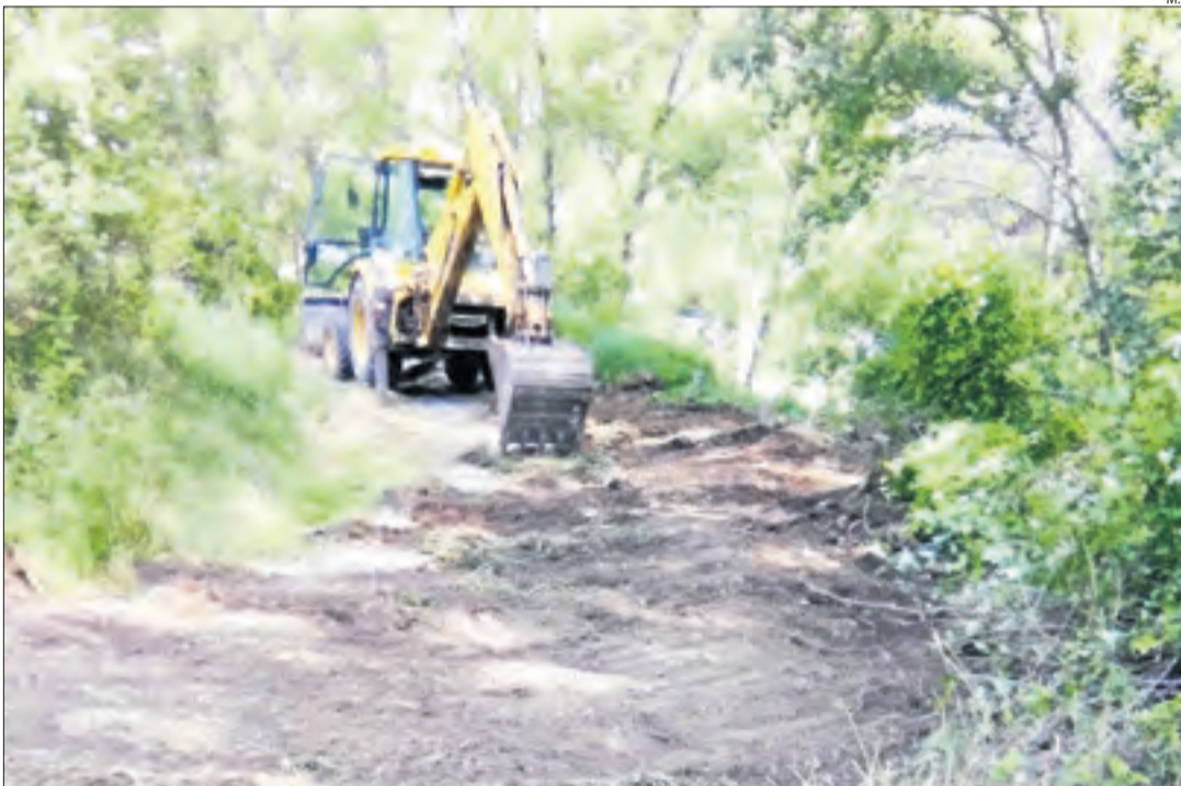
Les obres per fer transitable el camí que baixa a la zona de desembarcament de la Pobla de Segur.
