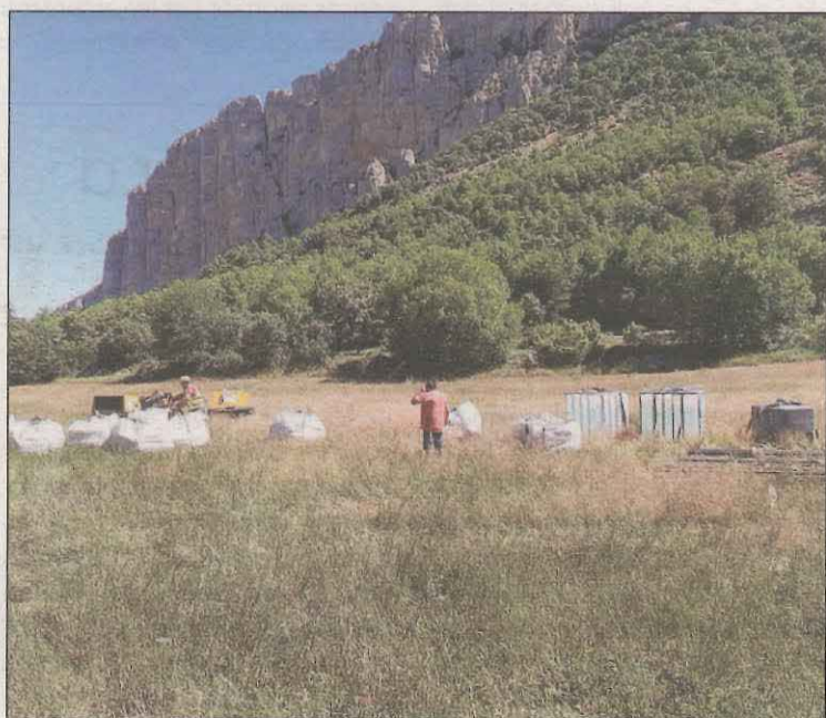
FOTO: Aj. Àger/ Es preveu que les obres durin entre 4 i 6 setmanes
