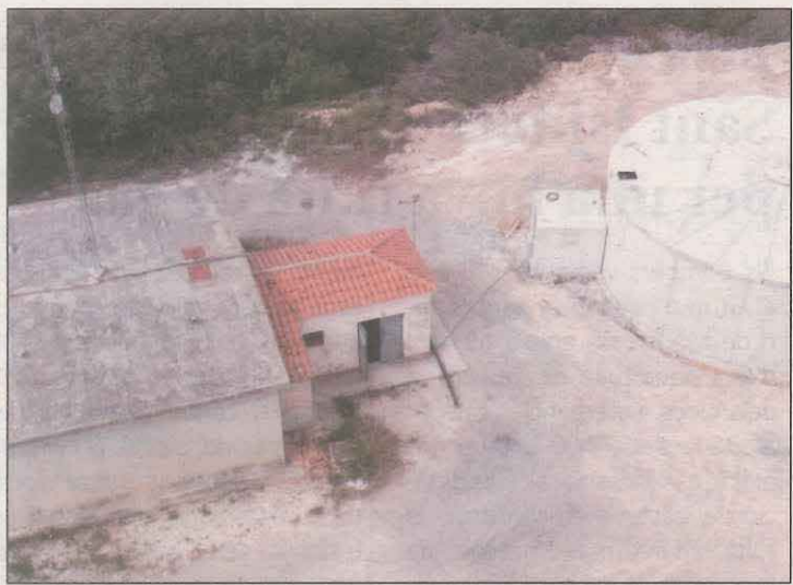
FOTO: Aj. Àger / Imatge del nou dipòsit que s'ha instal·lat
