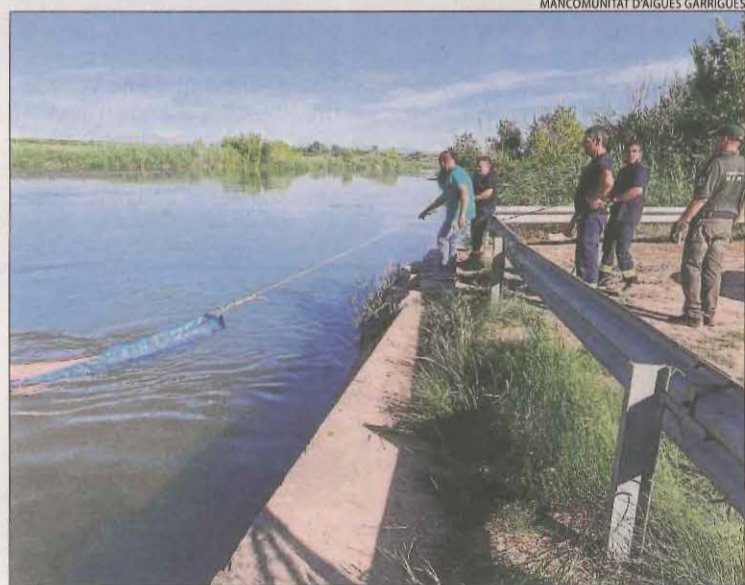
Un cordó de contenció instal·lat per la mancomunitat.
