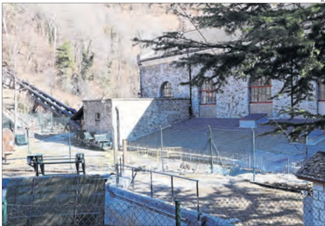
La central de Capdella, a la Vall Fosca, en una imatge d'arxiu.
