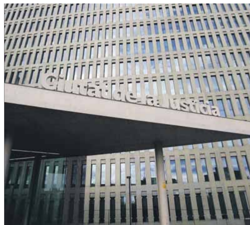
Detall d'un dels edificis de la Ciutat de la Justícia ■ QUIM PUIG
