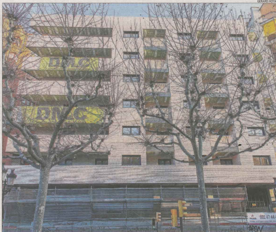
Tots els habitatges d'aquest edifici de rambla Ferran amb Ramón Castejón es destinaran al lloguer.
