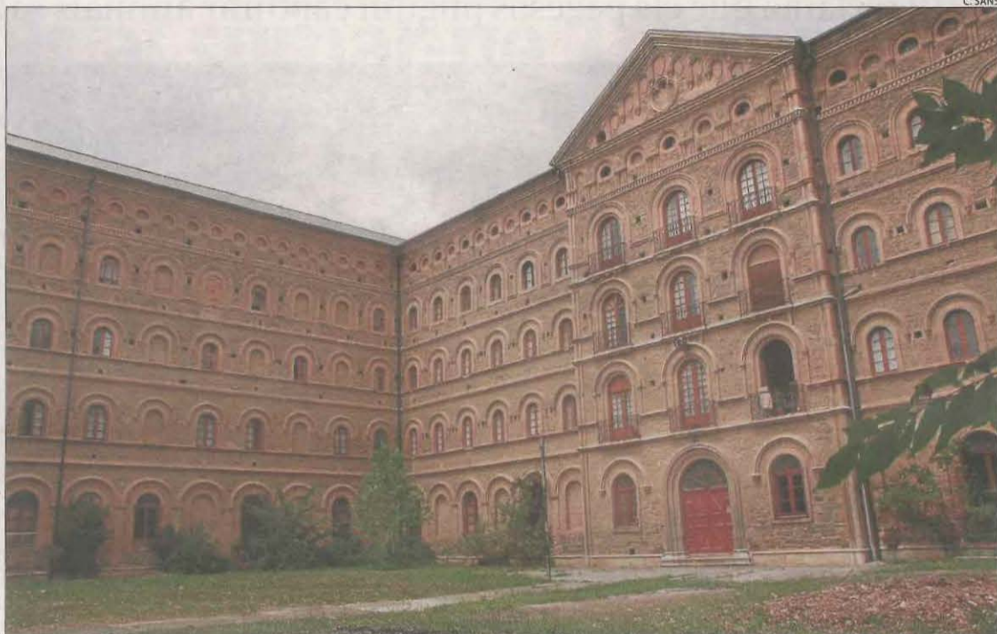
Vista del pati i de l'edifici imponent del Seminari de la Seu d'Urgell, construït en forma d'E.
