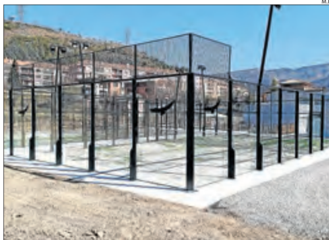
Les pistes de pàdel a la zona de la guarderia de la Pobla.
