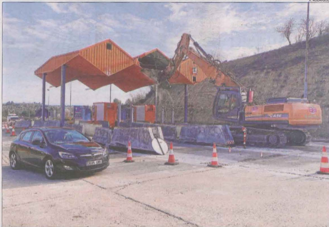
Els treballs de demolició de les casetes de peatge de l'Albi, que van començar ahir.
