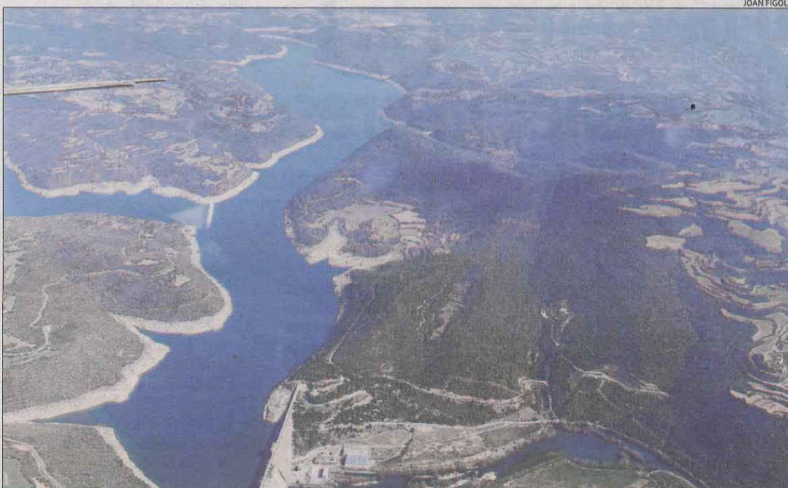
La presa de Rialb, embassament que en l'actualitat està al 43% de la capacitat.
