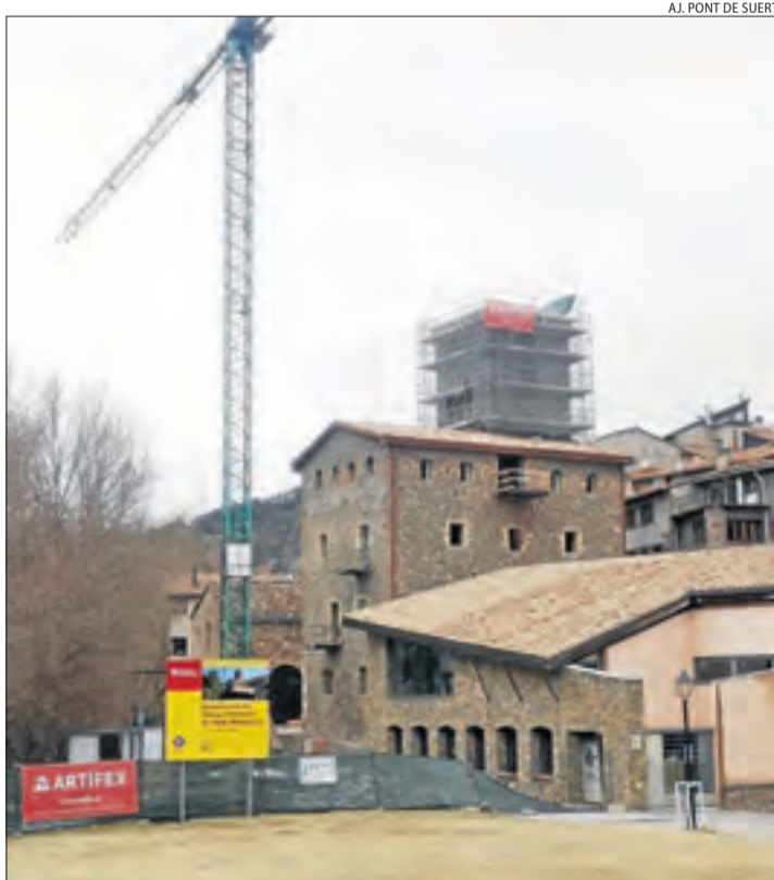
Desmunten la coberta de la torre del Palau Abacial ■ Les obres per instal·lar el futur arxiu comarcal de l'Alta Ribagorça al Palau Abacial del Pont de Suert inclouen la renovació de la coberta de la torre, actualment desmuntada. Està previst que el nou equipament obri aquest mateix any.
