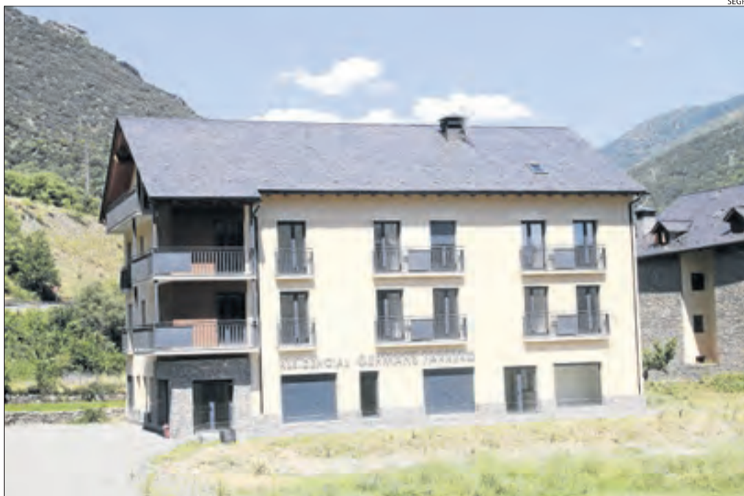
L'edifici de pisos tutelats de Rialp, pendent d'obrir després de finalitzar les obres.
