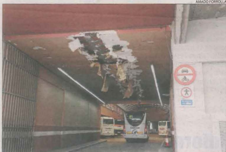
El forat deixat al sostre per la grua d'un camió.
