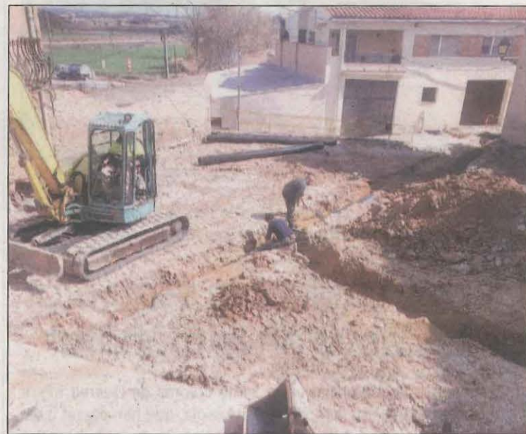
FOTO: J.G./ Les obres que s'estan fent per acabar les tasques de millora
