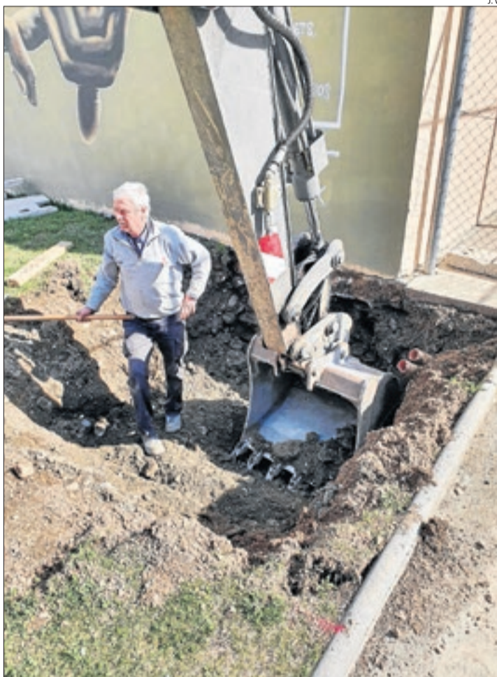
Les obres dels fonaments per a les bigues de l'estructura.
