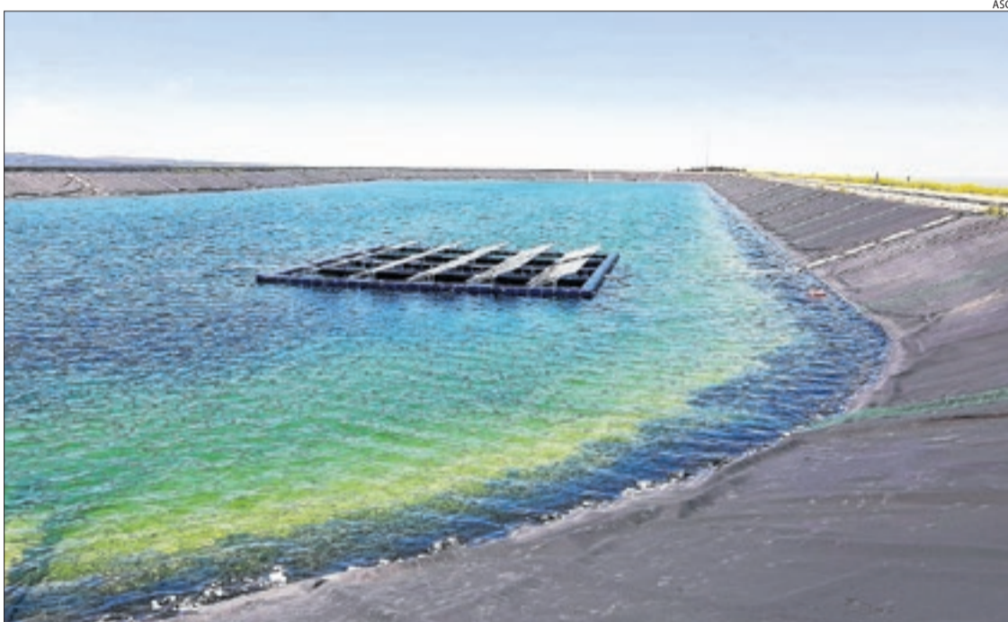
Les plaques solars a l'embassament de Bessons, el 2018, que un temporal de vent va acabar enfonsant.
