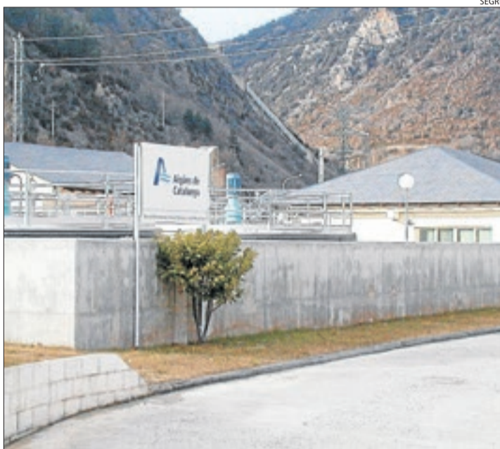
La planta depuradora del Pont de Suert.
