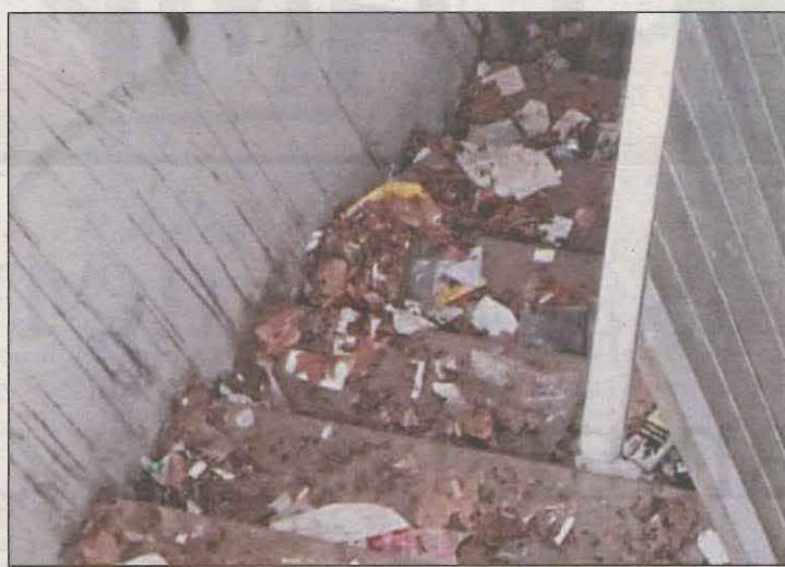
FOTO: L.M. / Brossa a les escales d'accés a l'aparcament de la Llotja
