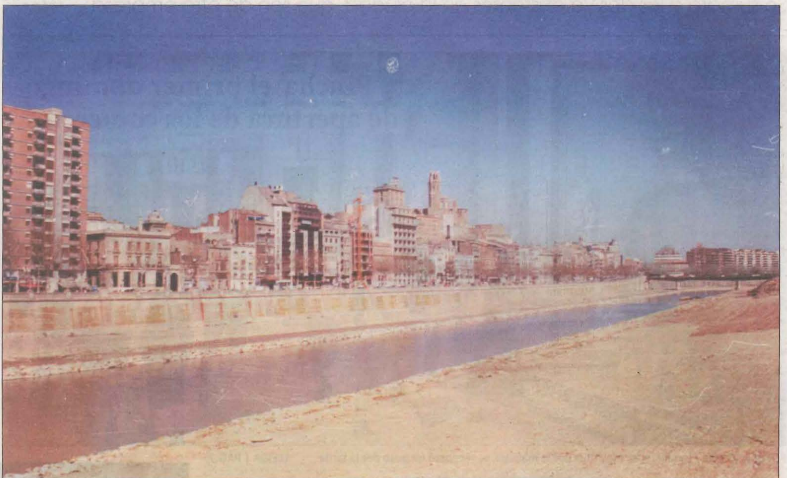
Obres de la canalització al marge esquerra del riu Segre. Al fons, el Turó de la Seu Vella / Fons Gómez Vidal (1994)
