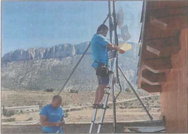
FOTO: Aj. Tremp / Els operaris instal·lant les antenes
