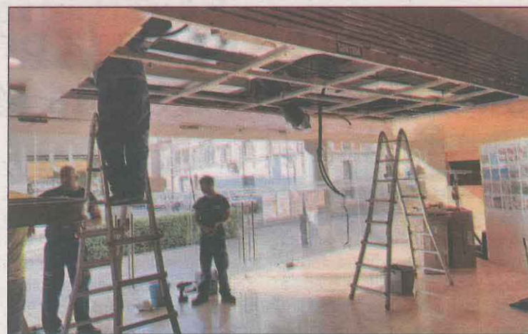
FOTO: Aj. Alcarràs/ Els tècnics realitzant la renovació del centre
