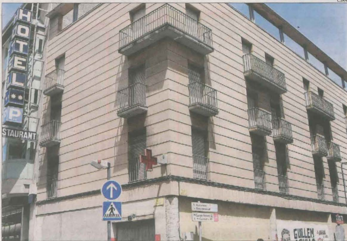
L'ajuntament de la Seu treballa en la reforma de Cal Pensament, on preveu habilitar 10 pisos.
