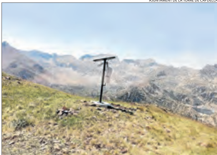
Una de les antenes que s'han instal·lat a la Torre de Capdella.
