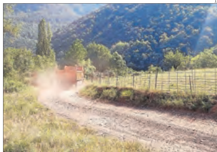
Treballs divendres a la pista que dona accés a Mencui.
