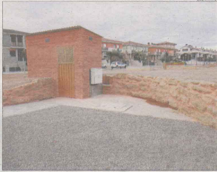
Torrefarrera va fer obres de gestió de l'aigua al recobrar el servei.
