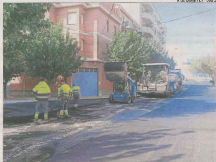
Els treballs en un carrer del barri del Sol Ixent de Tàrrrega.
