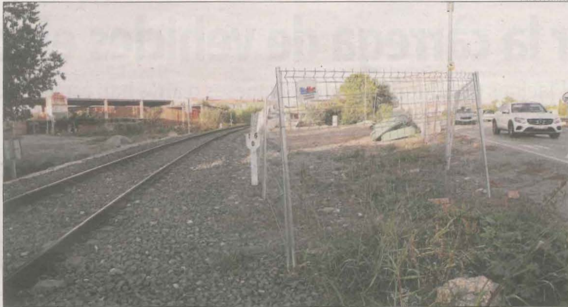
Les obres vora la via del tren de la línia de la Pobla on anirà el pas elevat, al costat de la C-13.
