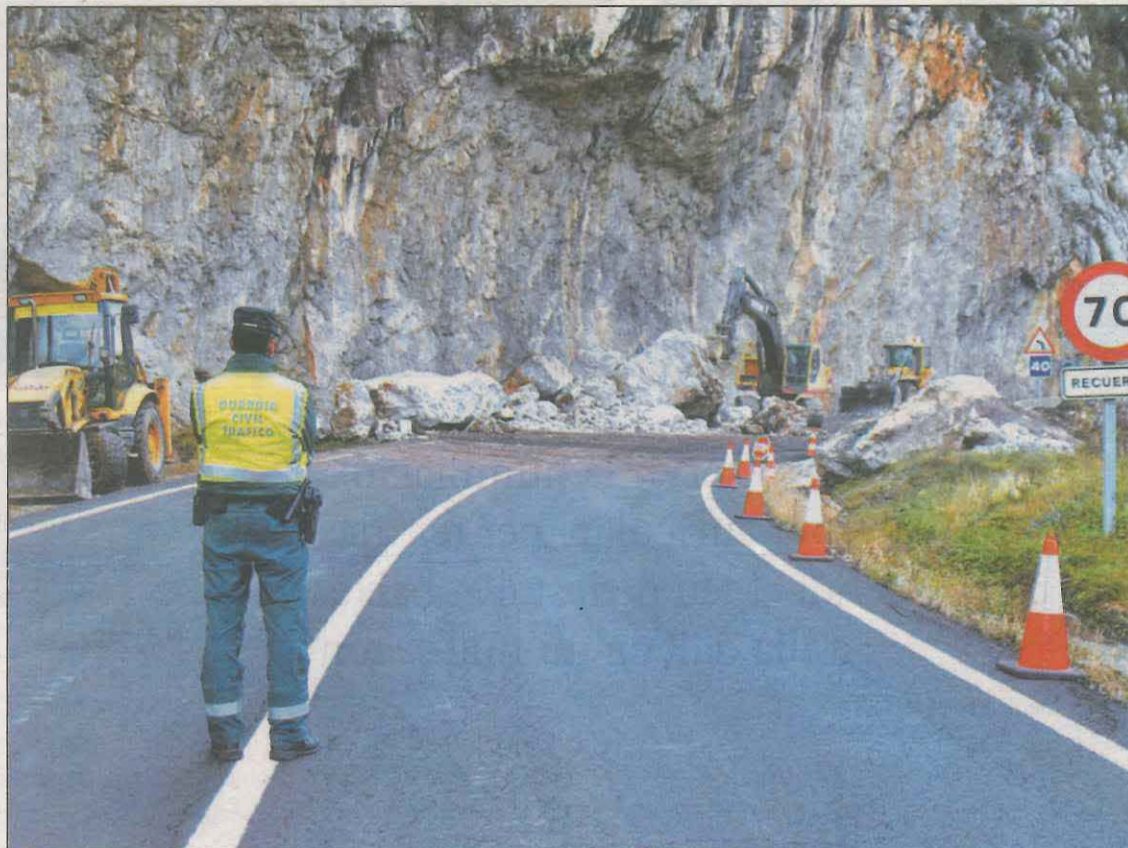
FOTO: Núria Castells/ Les màquines treballant per retirar les roques caigudes a la carretera
