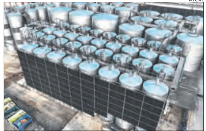
Imatge de la paret vertical de plaques solars de Raimat.
