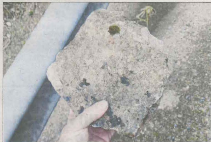
Una de les pedres de la pluja de roques a la carretera C-13.
