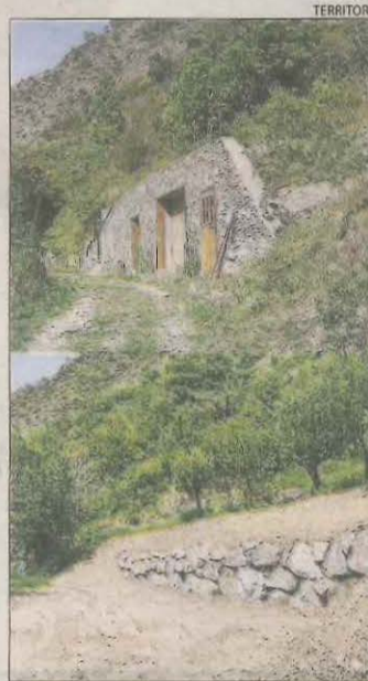
Habitatge demolit a Vielha.
