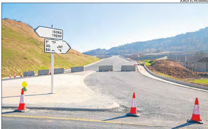
El tram de la variant que queda pendent d'acabar.
