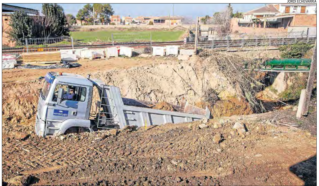
Les obres per evitar el pas a nivell del tren pel centre de Térmens.
