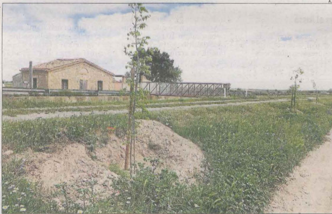
Una de les casetes del canal d'Urgell al seu pas per Arbeca amb arbres plantats i passarel·la nova.
