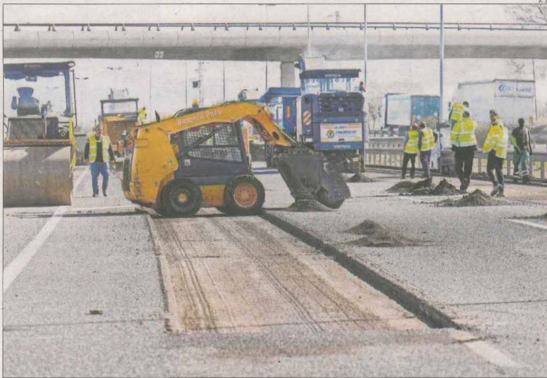
La primera jornada d'obres per renovar el ferm de la variant de l'A-2 a Cervera.
