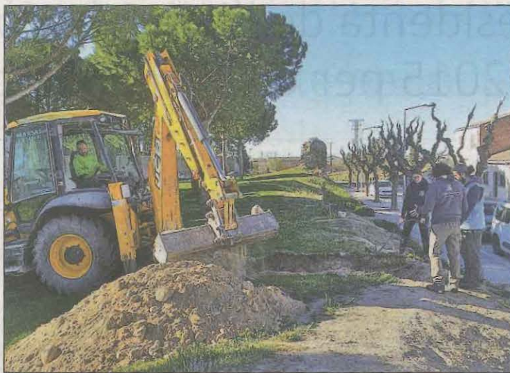
FOTO: Paeria de Balaguer / Imatge dels treballs que s'estan realitzant
