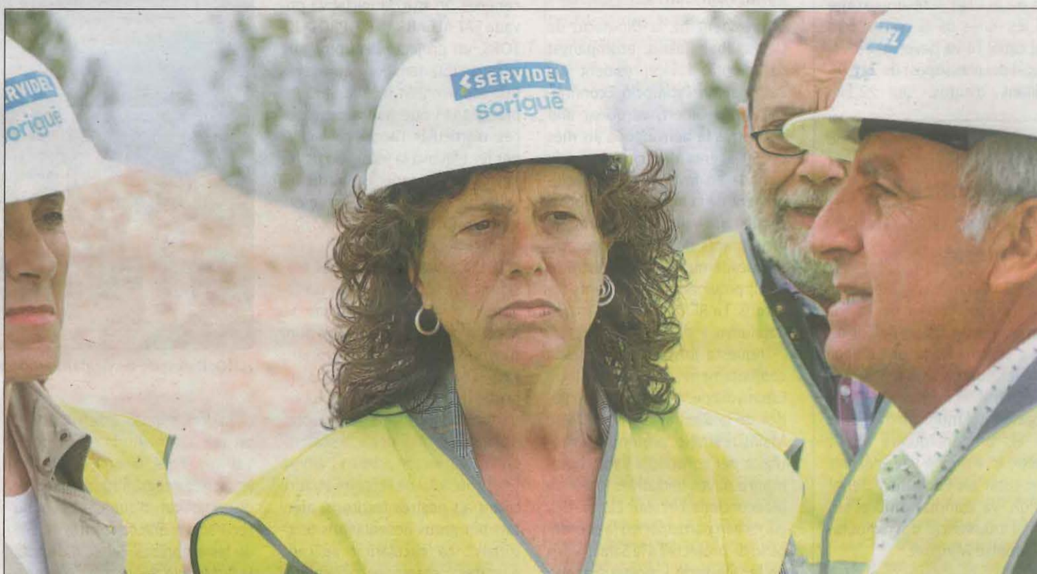
FOTO: ACN / La consellera d'Acció Climàtica va visitar ahir a Valls (Tarragona) obres de modernització de regadius
