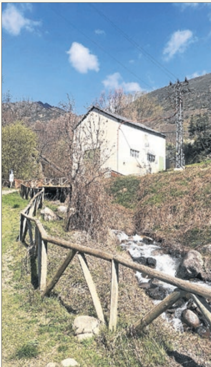
La minicentral hidroelèctrica d'Alós d'Isil.
