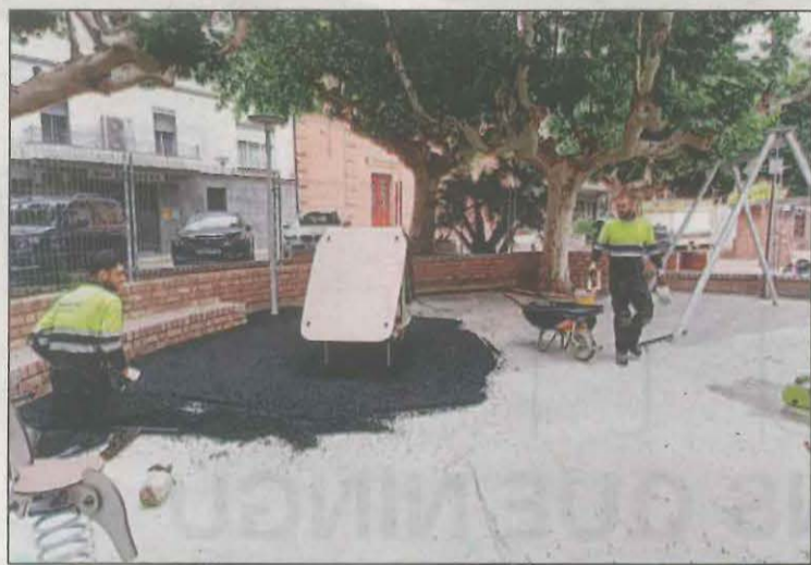
FOTO: Aj. Bellpuig / Operaris treballant en la renovació de l'espai
