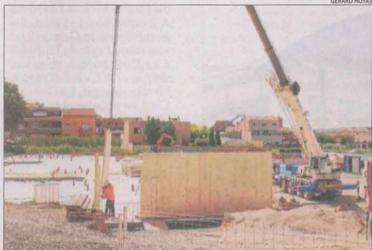
Operaris aixecant els murs amb ajuda d'una grua.
