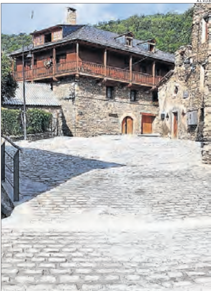
El nou paviment que s'ha instal·lat a Còll.
