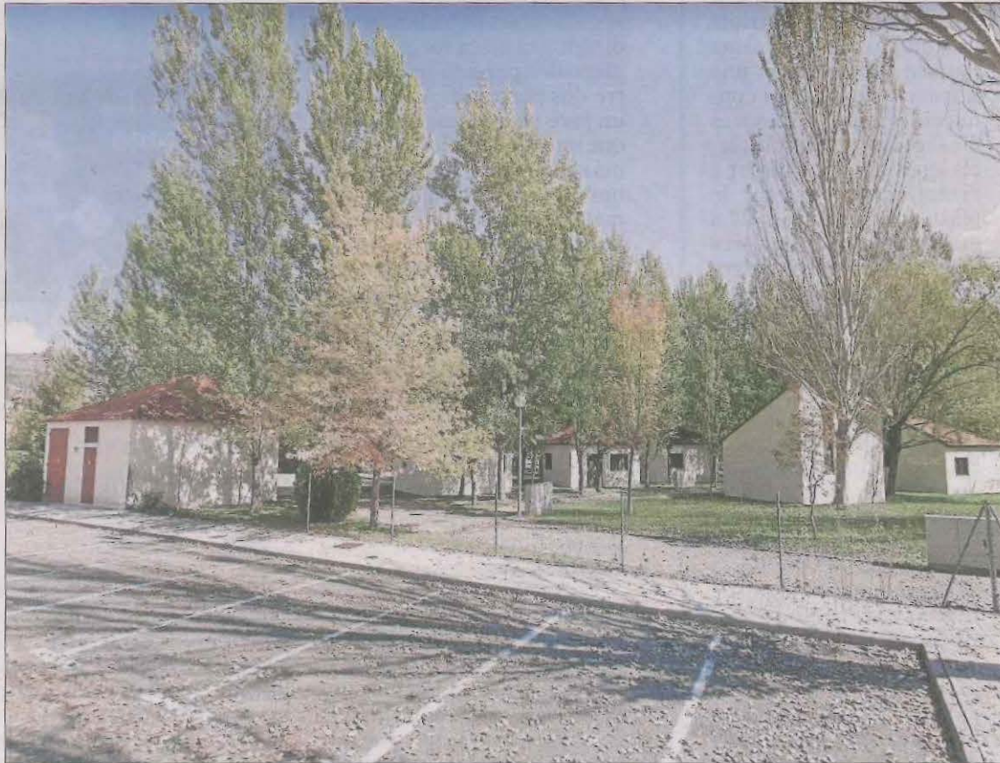
Els bungalows de l'àrea vacacional de la Pobla de Segur construïts a primers dels noranta.
