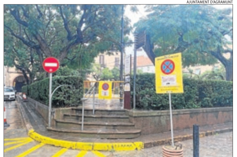
Precinten la plaça Mercadal d'Agramunt ■ La Policia Local d'Agramunt va precintat ahir l'accés per als vianants al centre de la plaça Mercadal per perill de desprendiments de les branques dels arbres. Tampoc es pot estacionar a l'entorn.
