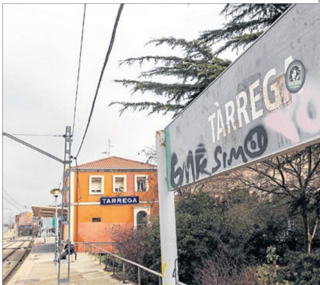
Pintades a l'estació de Tàrrega, una de les que la Generalitat reclama arreglar.
